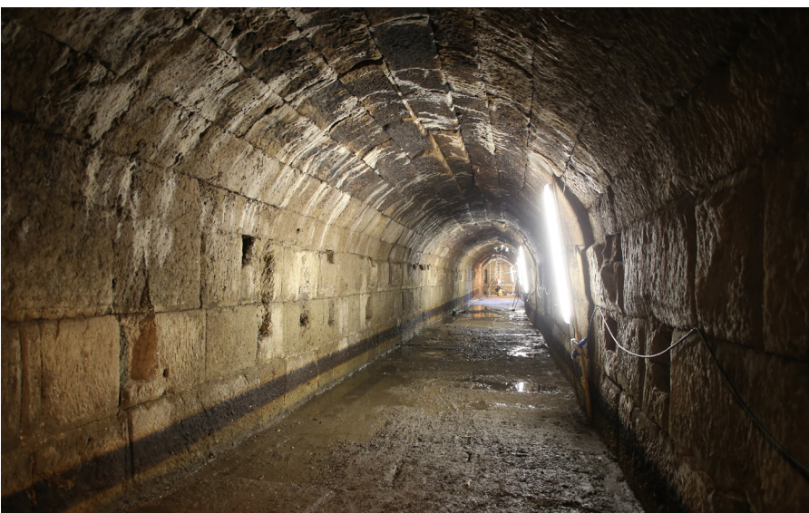
In alto: Le indagini eseguite per la realizzazione della Linea C-Tratta T3 della Metropolitana. L'installazione di condotti in pvc ha consentito di incanalare il flusso idrico e prosciugare temporaneamente il condotto consentendo di esaminare il fondo e svolgere altre indagini non invasive
