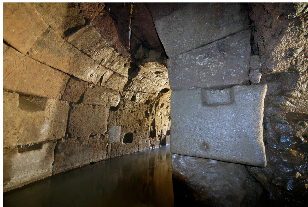
La Cloaca Massima sotto il Vicus Tuscus , l'antica strada che dal Foro Romano conduceva al Tevere. Qui il tracciato forma un gomito, forse allo scopo di ridurre la pressione delle acque del Tevere in risalita nel condotto durante le esondazioni
