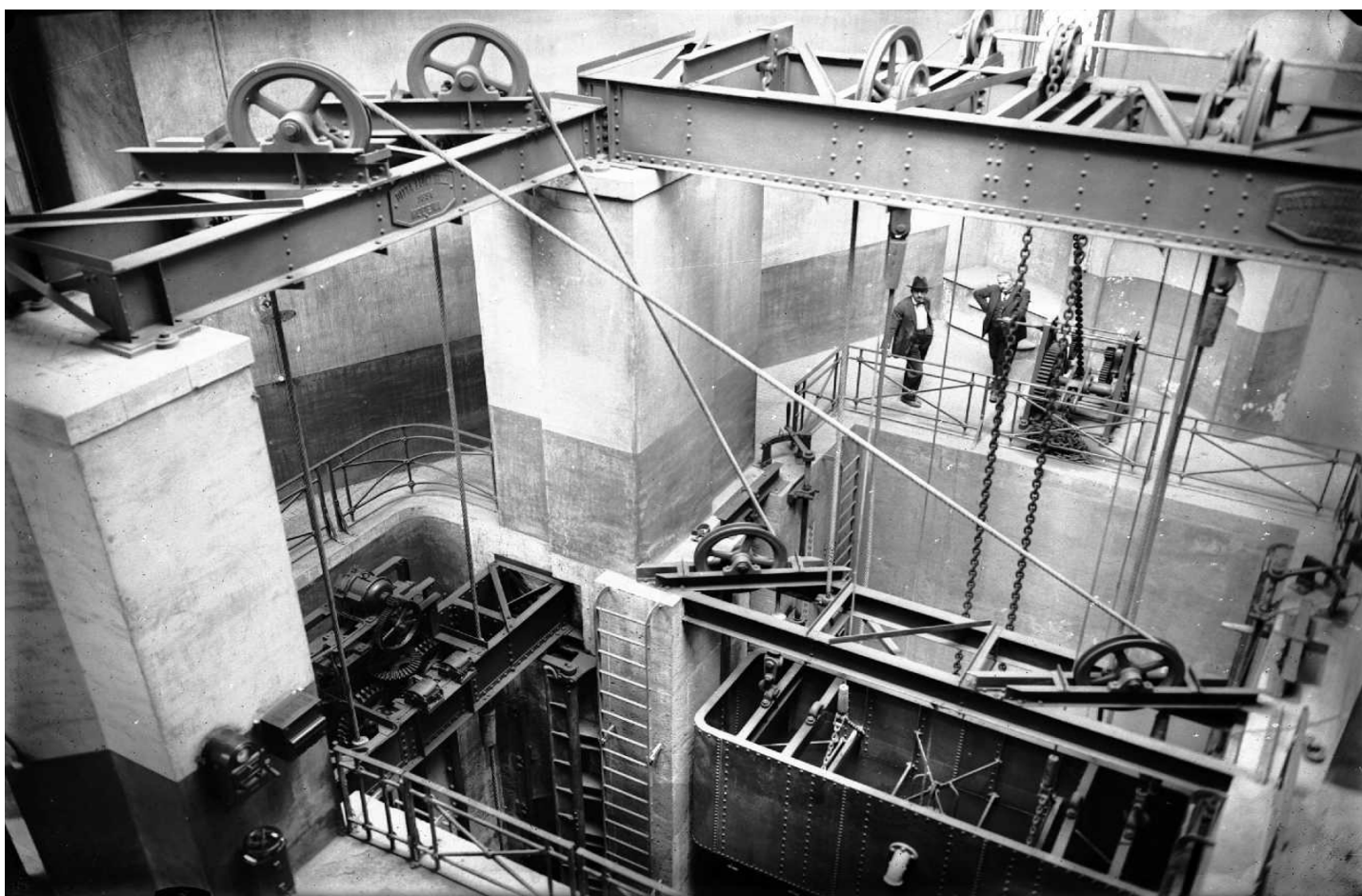
Il sistema di paratoie del manufatto di incrocio presso Bocca della Verità, 1926 (ASR, USTAR, II versamento, lastre, scatola n. 115)
